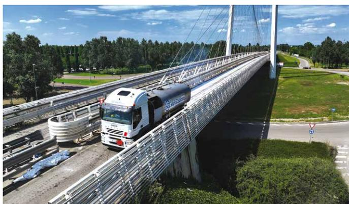
10. La spruzzatura del bitume modificato con cisterna spanditrice
