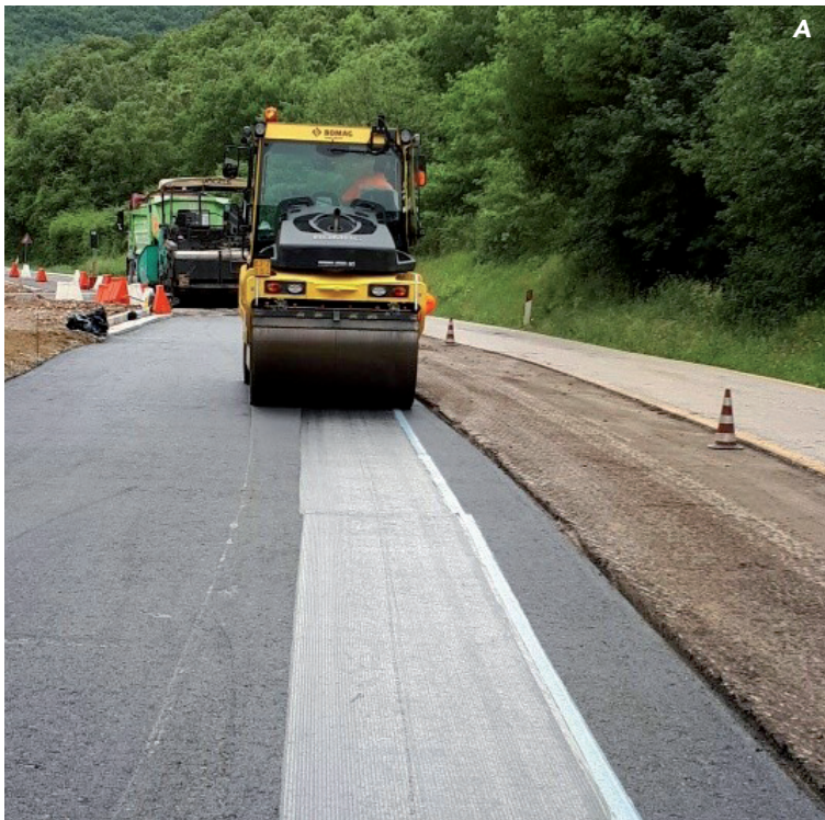
5A e 5B. Fasi finali del ripristino del manto stradale dopo la stesa del geocomposito con il passaggio del rullo e della finitrice
