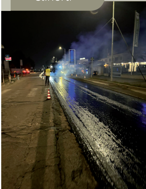
4. La stesa di una seconda mano di geomembrana
