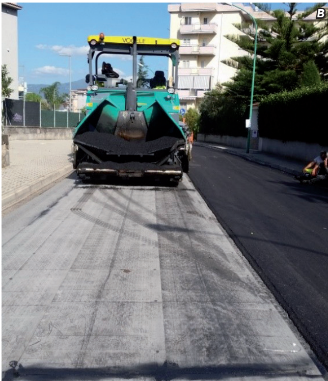
5A e 5B. Fasi finali del ripristino del manto stradale dopo la stesa del geocomposito con il passaggio del rullo e della finitrice
