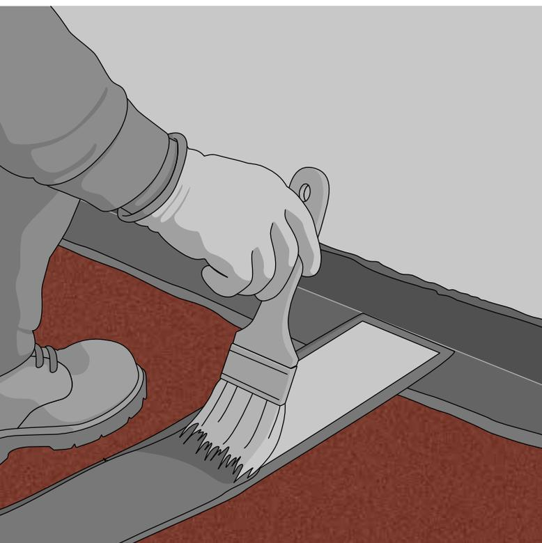
3. Applicare una seconda mano d'impermeabilizzazione liquida **VALPUR FAST** e attendere i tempi di presa e asciugatura.
